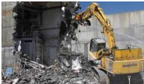
Рис. 3.2.6.1 Процес знесення будівлі
